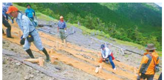
聖平上部の土砂流出防止マット設置
