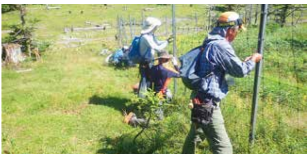
聖平の防鹿フェンス修理
