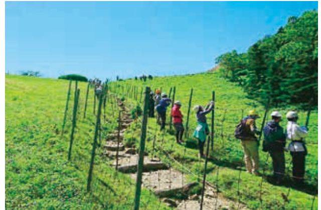
三伏峠の防鹿柵修繕作業
