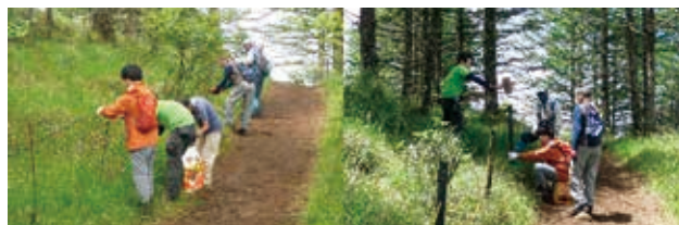
登山道の損傷ロープの撤去と杭とロープの新設作業
