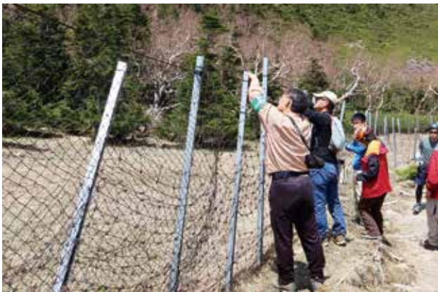
三伏峠の防鹿柵の新修繕方法 (令和5年5月28日)
